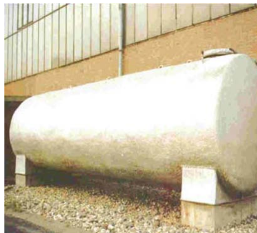
Im Sprühverfahren mit PUR-Hartschaum gedämmt und mit hellem UV-Schutz Lack beschichteter Lagertank.
