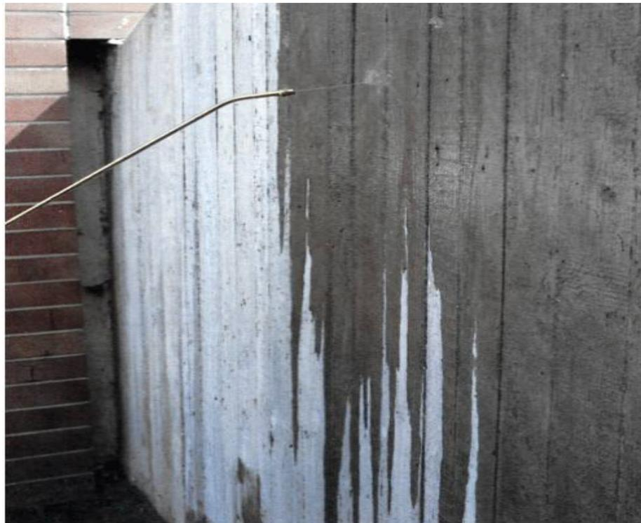
HydroBloc®Si-742-K *aqua* bildet keine Filme und behindert nicht die Wasserdampfdiffusion aus dem Baustoff. Das Produkt wird als Konzentrat geliefert, wird vor der Applikation
